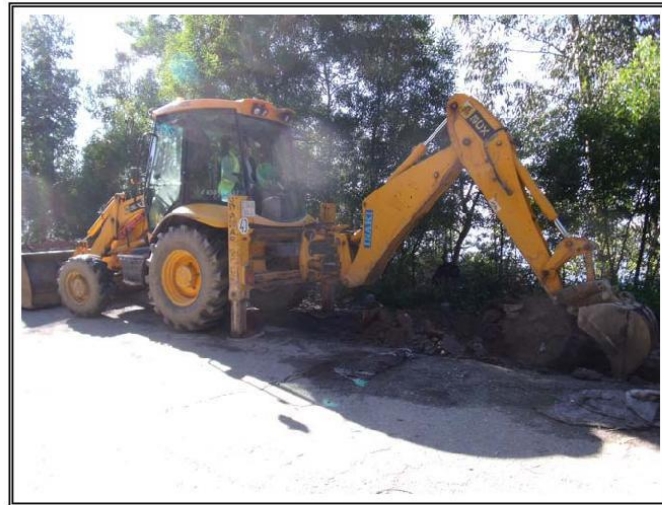
Fotografía del emplazamiento de la calicata C-2
