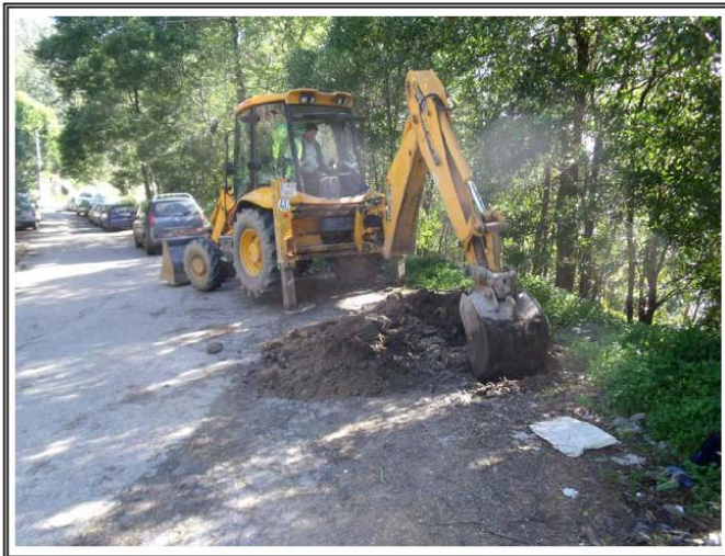
Fotografía del emplazamiento de la calicata C-3
