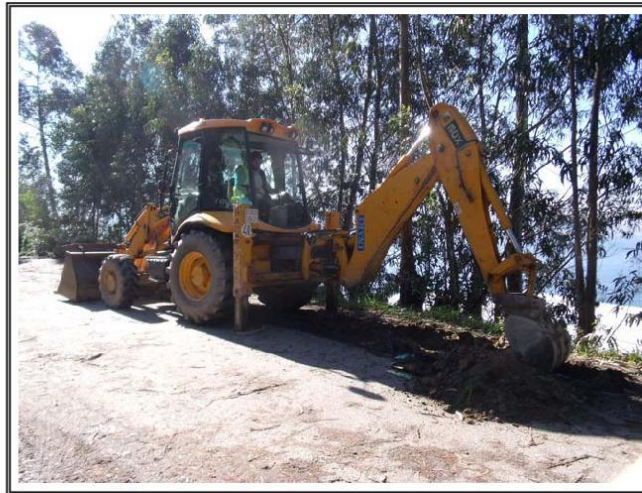
Fotografía del emplazamiento de la calicata C-1
